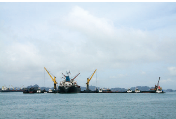
Toàn cảnh khu Hòn Nét trong công việc.
